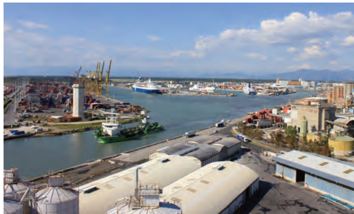
Canale industriale dove verrà realizzato il microtunnel
