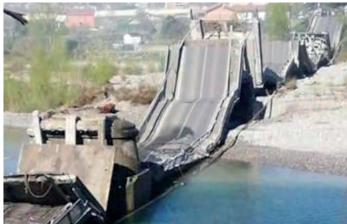
Il ponte di Albiano crollato sul Magra
