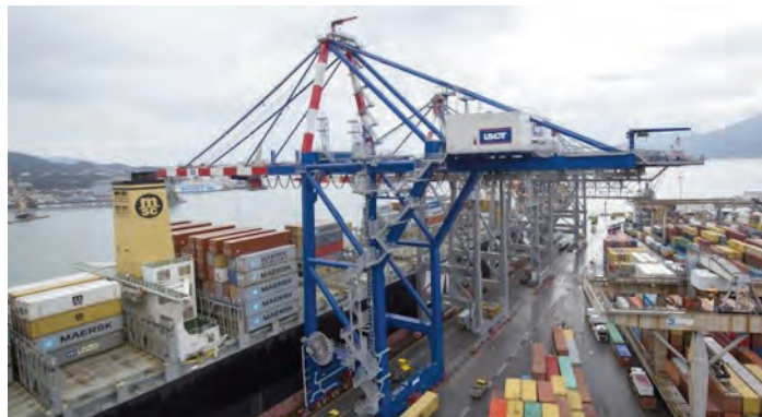
Veduta del terminal Contship a Spezia
