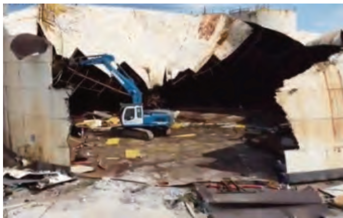
Demolizione dei serbatoi Eni Esso
